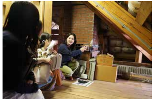
インブリー館屋根裏の見学
