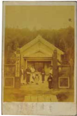
【写真 2-1】九十九里教会の会堂と幸三たち 1893年7月31日撮影 九十九里教会所蔵
